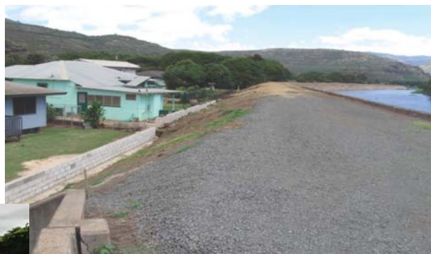
Waimea Levee, Kauai
